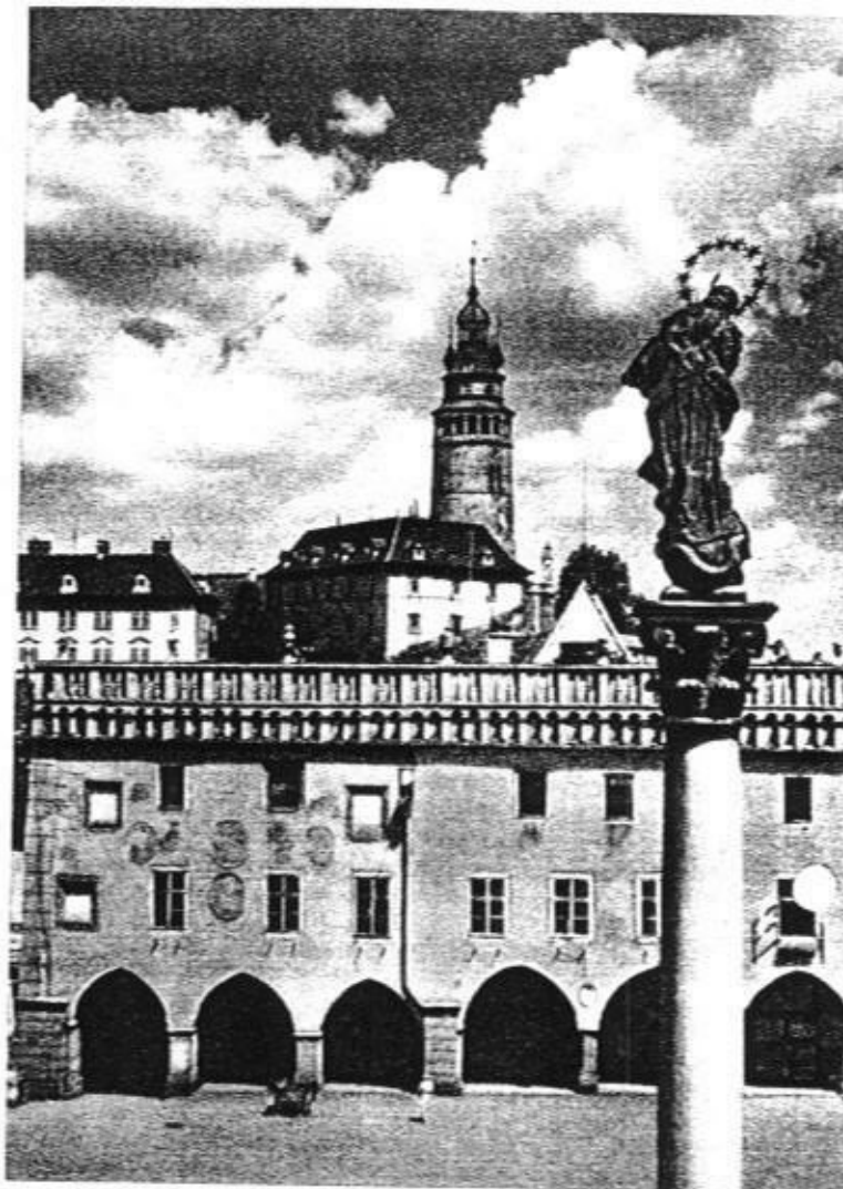
Das am Fuße des Böhmerwaldes gelegene Krumau mit Blick auf den Schloßsturm. Foto: Südd. Verlag
